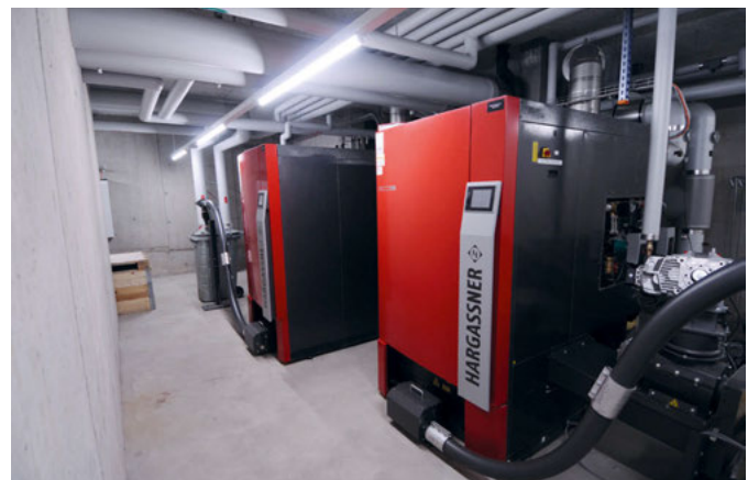
Das technische Netzwerk der Siedlung verbindet alle Gebäudetechnikkomponenten via Glasfaser (oben links). Damit kann der Betriebszustand der Heizungspumpen (oben rechts) oder der beiden Pelletsessel (unten rechts) überwacht werden. Der sozialen Vernetzung der Bewohnerschaft dienen die Laubengänge (unten links).
