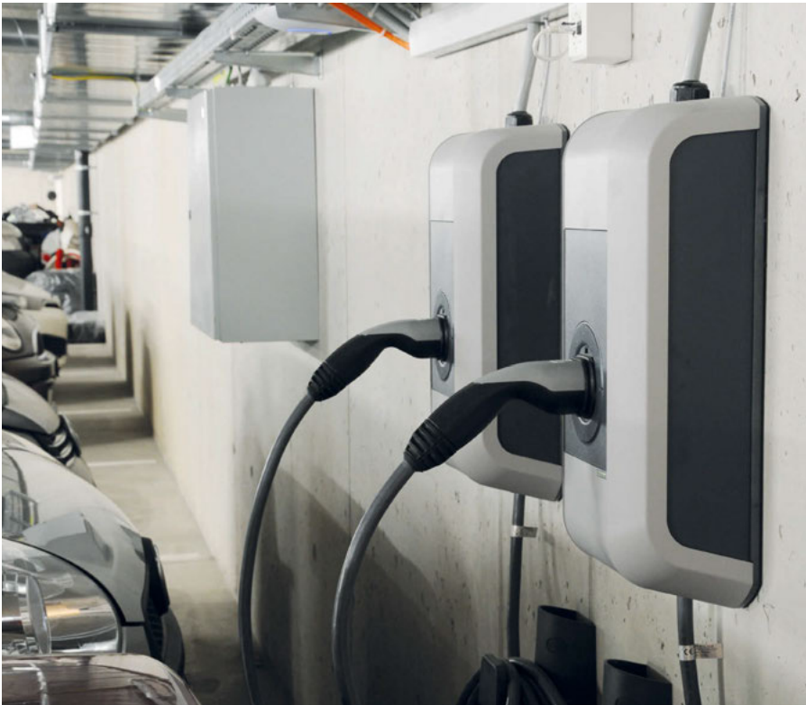
In der Tiefgarage sind zwei EV-Ladestationen verfügbar. So können die Genossenschafterinnen und Genossenschafte ihre Autos mit dem selbst produzierten Solarstrom laden.
